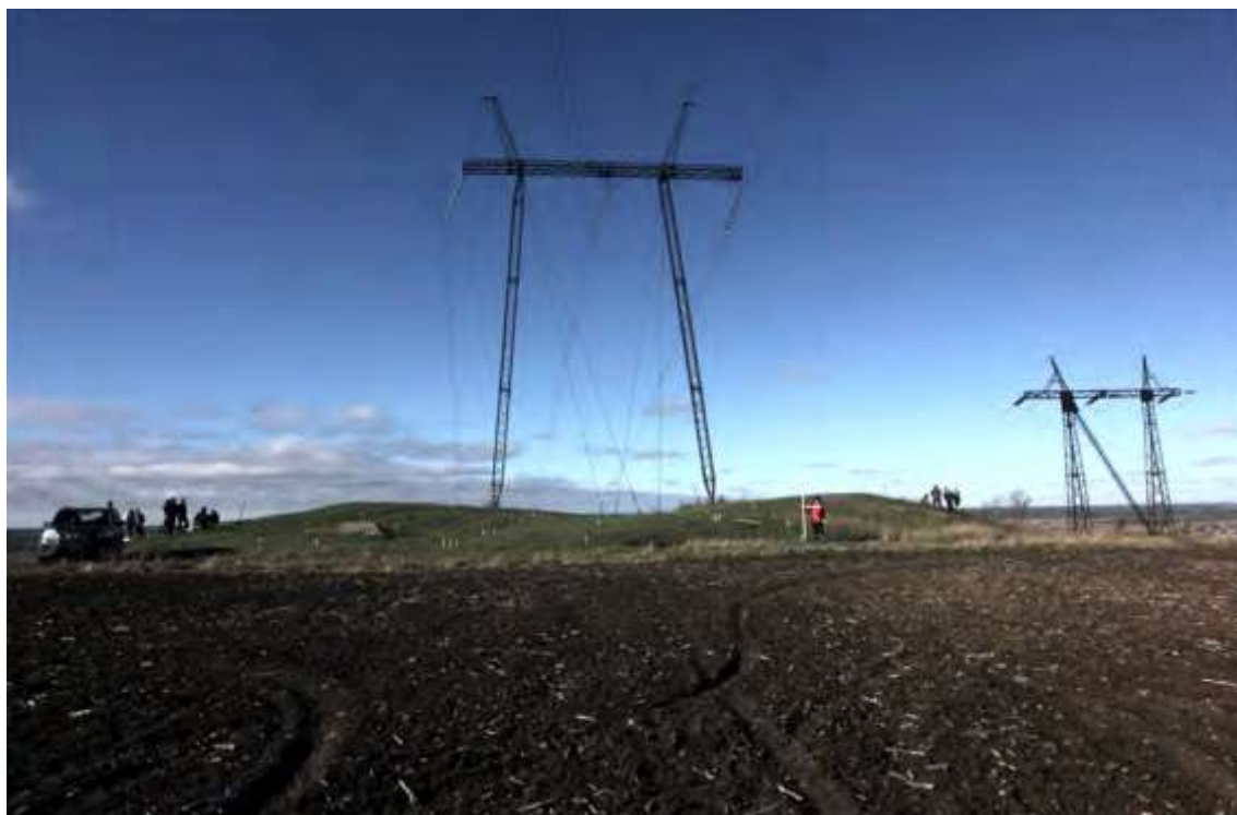
Рис.4. Фото на опору № 15 высоковольтной линии и рядом находящиеся курганы № 1 и № 4 (т. н. объект «Городище»). Вид до начала работ.
