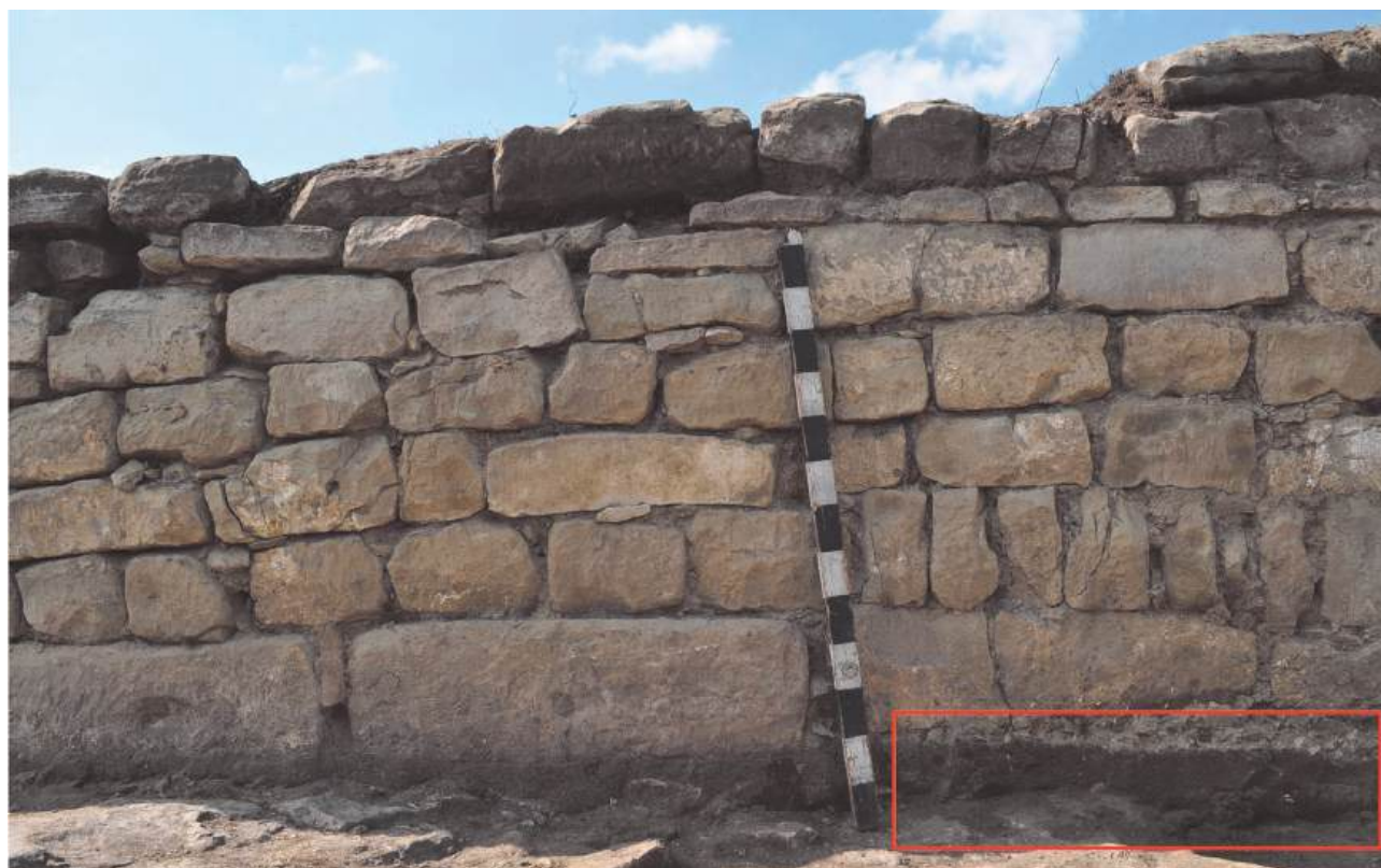
Рис. 8. Фрагмент панцирной кладки стены Хумаринского городища (по У.Ю. Кочкарову) (красным выделена подсыпка)
